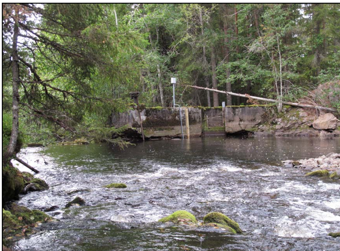
Figur 6.11. En eldre demning i nedre del av Deia fungerer som et absolutt vandringshinder for fisk, og ligger om lag 1.3 km oppstrøms utløpet til Renavassdraget.
